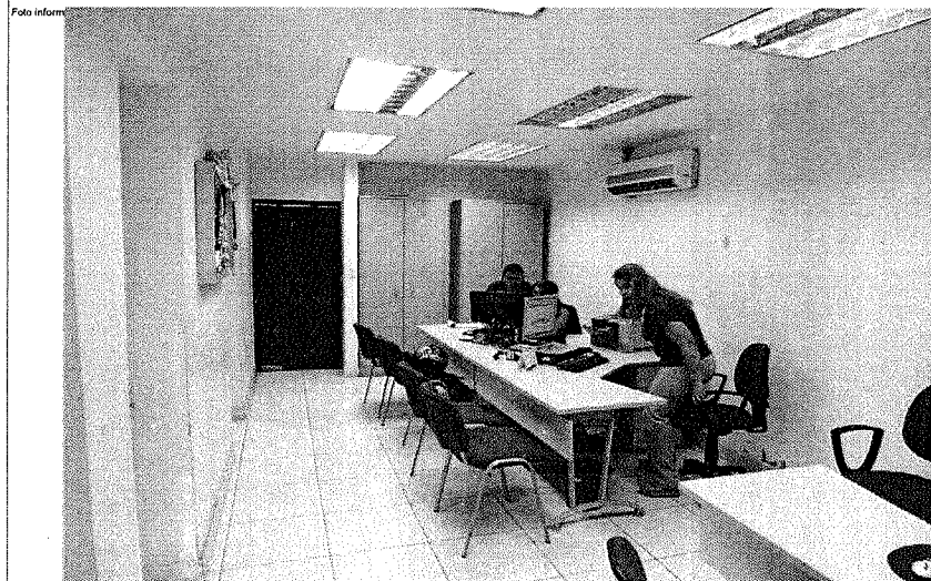
Foto inform Comentarios: OFICINAS, LAMPARAS DENIVELADAS Y BOMBILLOS FUNDIDOS
