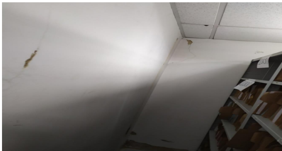
Fotografía 1 Daño mampostería estructural.
